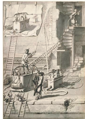
Тушение пожара машиной Ван дер Гейде
